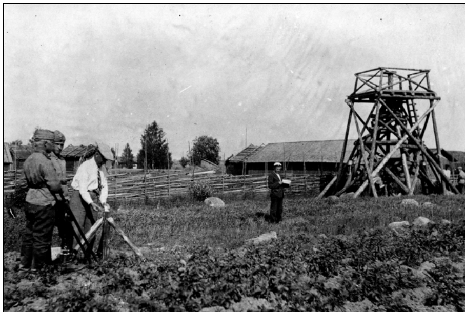
Kuva 10. Invarlankamittausta Ilmajoella vuonna 1930. Apumiehinä on varusmiehiä ja kirjuriina ylioppilas. Taustalla on suurennusverkkoon kuulunut torni. Invarlanka on pingotettu 10 kg:n punnuksien avulla, jotta vetojännitys jokaisessa mittauksessa on tarkalleen sama. Kuva: Geodeettisen laitoksen arkisto.
