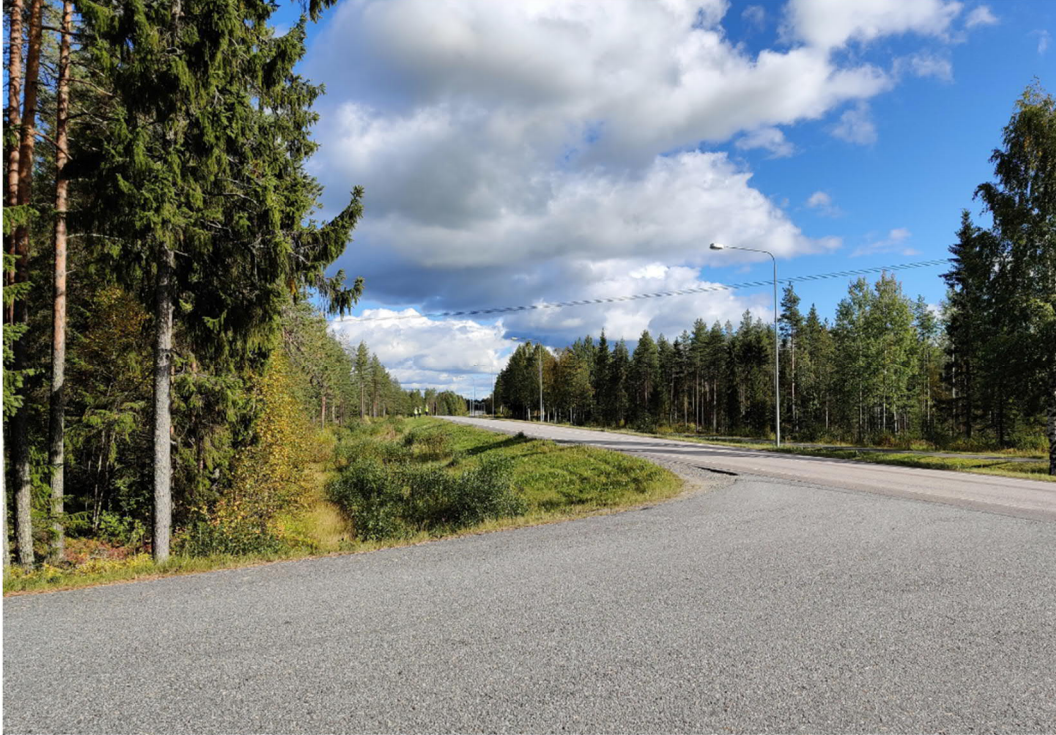
Kuva 11. Pysäköimisalueelta tulevan liittymän suuntaan
