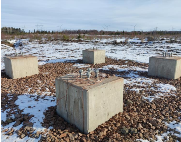
Valmis vapaasti seisovan pylvään valettu perustus
